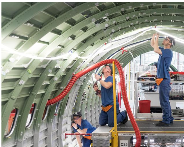
Pose des circuits vitaux de l'appareil : câblages électriques, tuyauterie (air, hydraulique, eau), conditionnement d'air, isolation, planchers.
