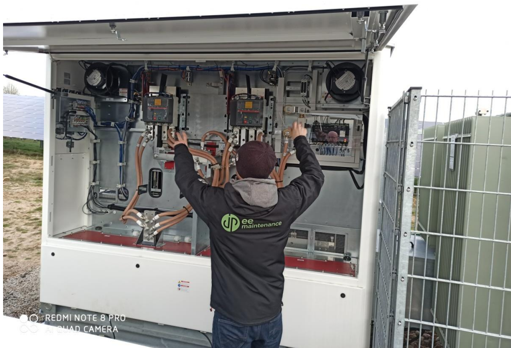
Un poste de transformation courant continu vers courant alternatif
